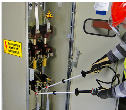
Měření s HS 11 na 10 kV transformátoru
